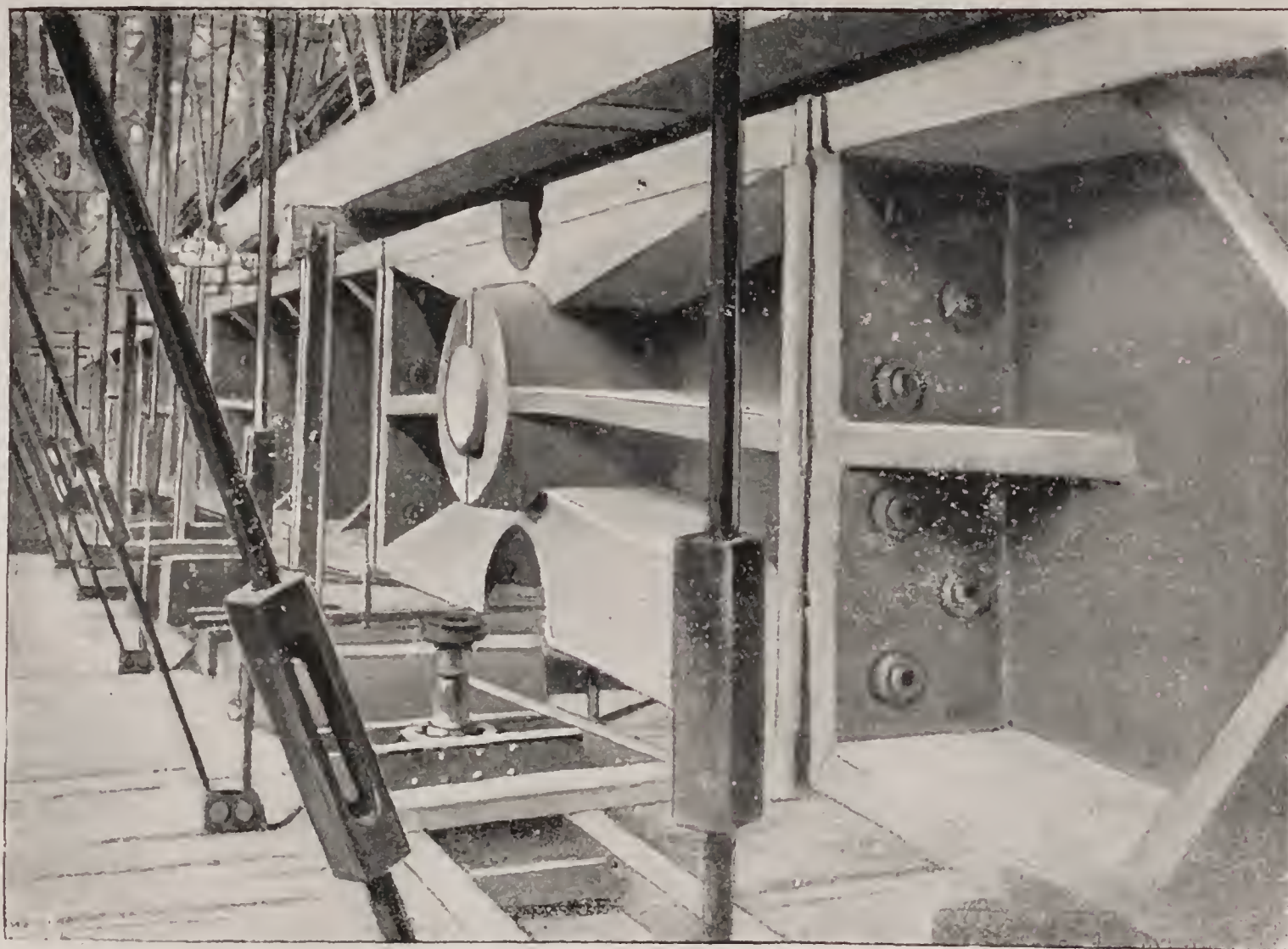
SUR LES CHANTIERS. — Voussoirs de clé et rotule centrale d'un arc au pont Alexandre.
